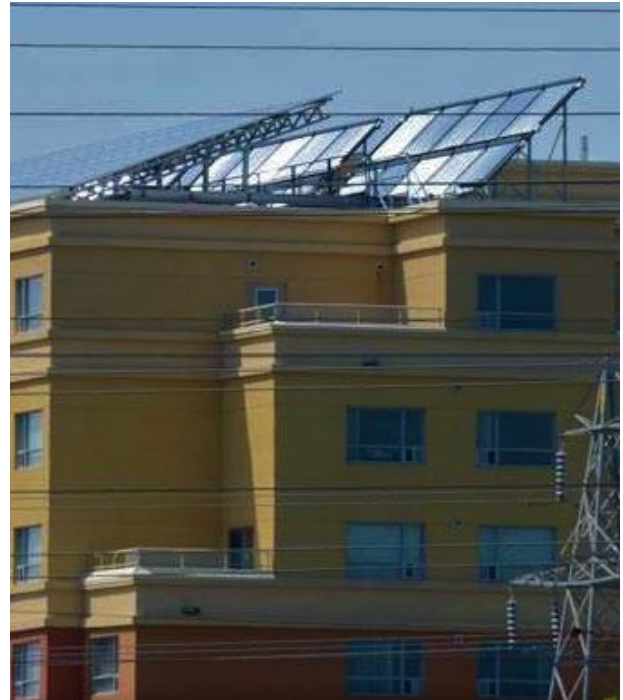
Panneau solaire sur plusieurs logements, Dundas, ON. Photo de Kim Perrotta.
